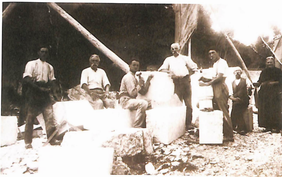
Cava delle Preare, anni '10 del Novecento. I priari sono al lavoro con punta e masséta; in basso a sinistra si scorge la squadra di ferro, altro strumento indispensabile. Lunghi tronchi di abete sorreggono l'ampio telone orientabile che li ripara dal sole.
