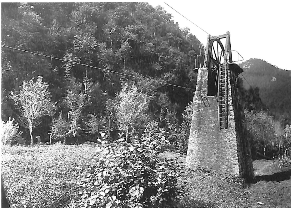
Illustrazione 6. Pilastro intermedio per il sostegno della fune teledinamica, nel periodo in cui l'impianto era funzionante.
