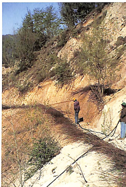
Semina a pressione con prevalenza fino a 100 m.
