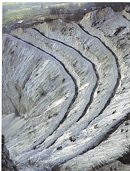
Terrazzamenti completati con rinforzo longitudinale.
